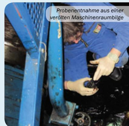
Probenentnahme aus einer verölten Maschinenraumbilge
